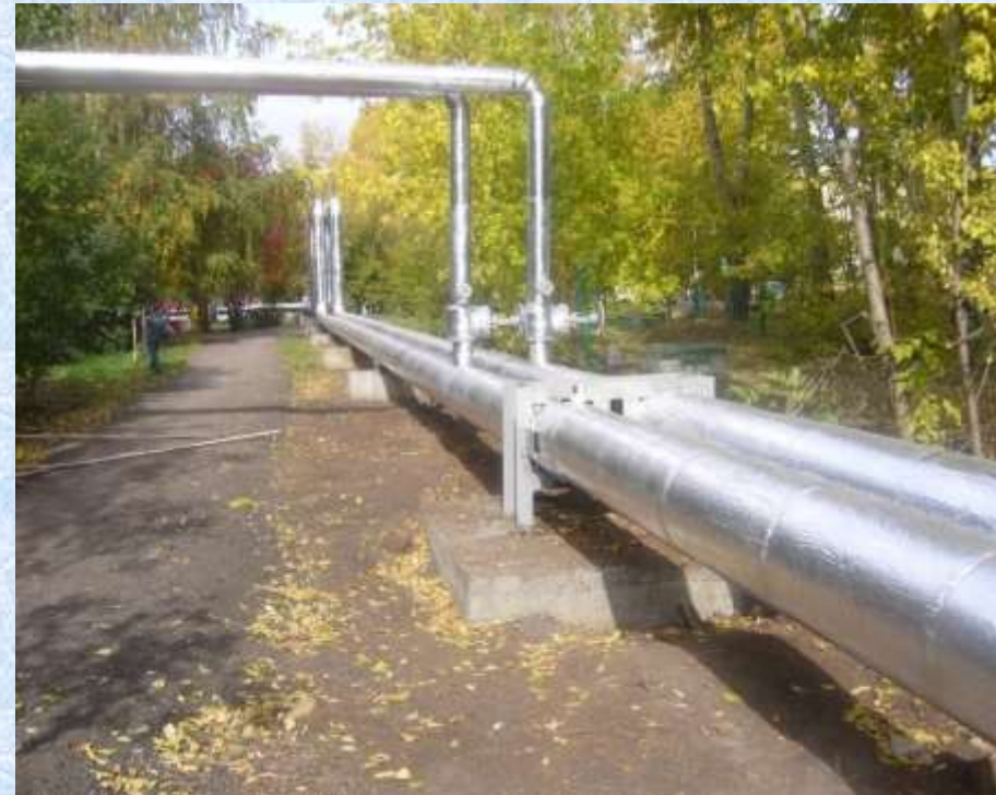
После монтажа изоляции
