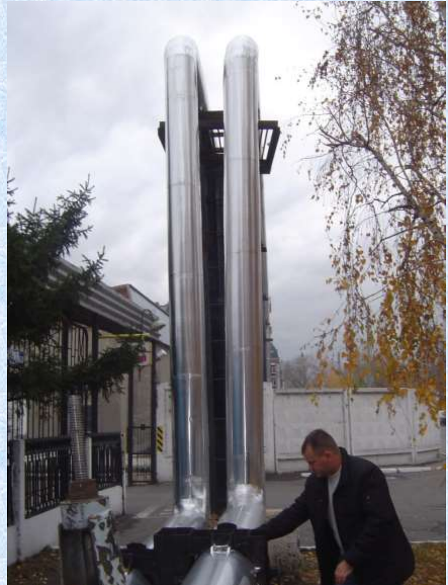
После монтажа изоляции
