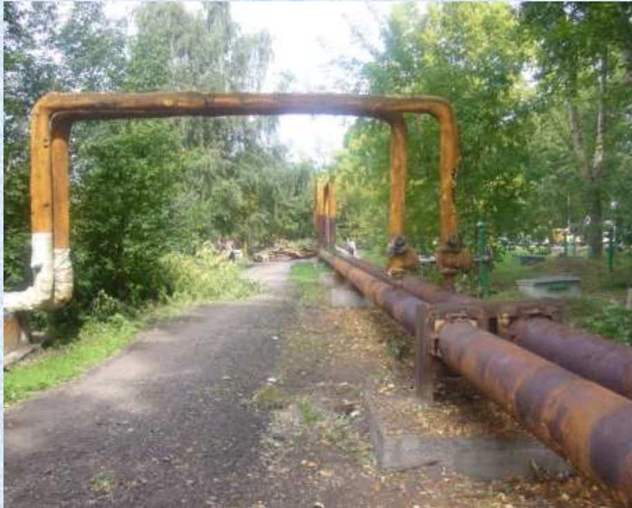
До монтажа изоляции
