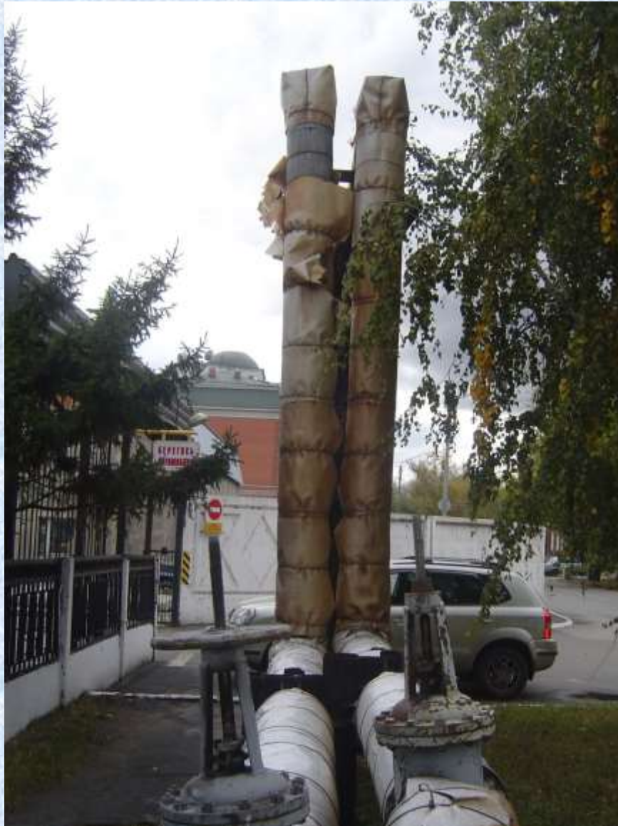
До монтажа изоляции
